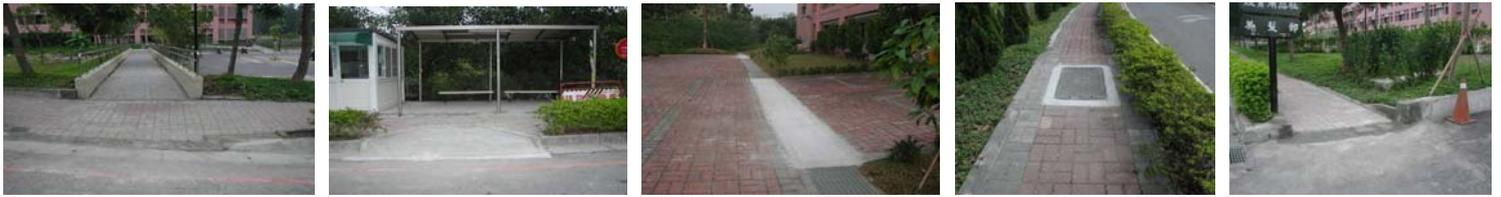
斜坡道改善 候車亭斜坡出入口 建築物入口水溝加蓋 人孔蓋與地面高度一致 高低差改成斜坡
