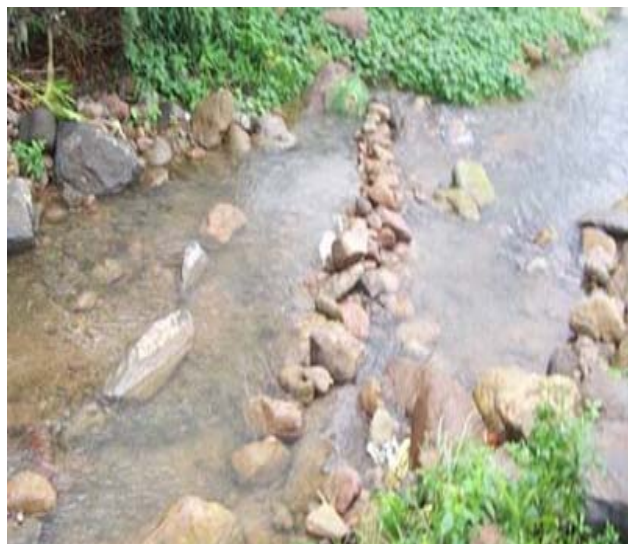
圖三 石梁固床工
