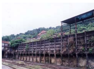
■菁桐車站旁之卸煤區
