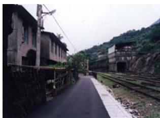
■菁桐街上之舊礦區員工宿舍
