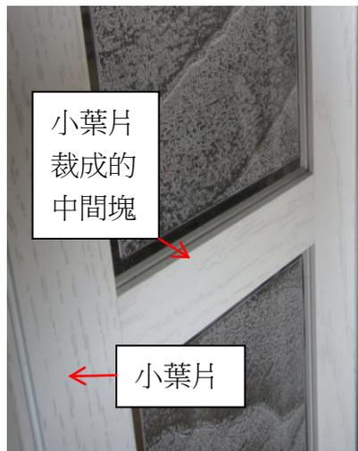
圖 3-21 舊型組合式 PVC 塑膠拉門
