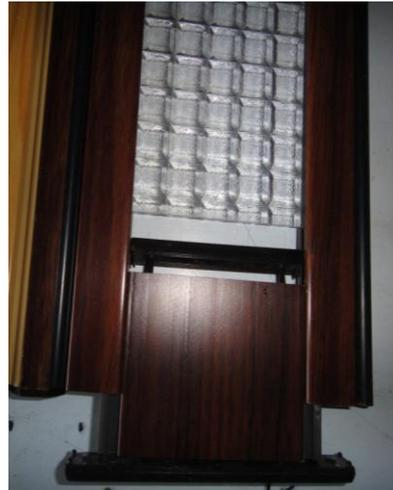
圖 3-26 舊型組合式拉門葉片
